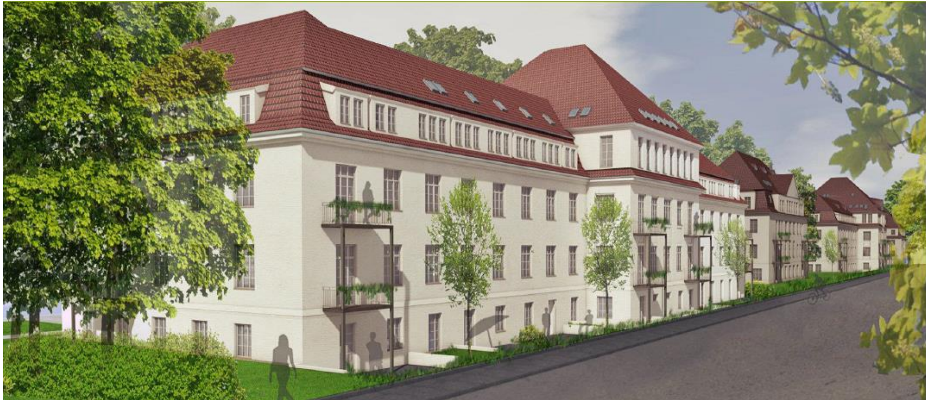
Denkmalsanierung einer ehemaligen Kaserne
